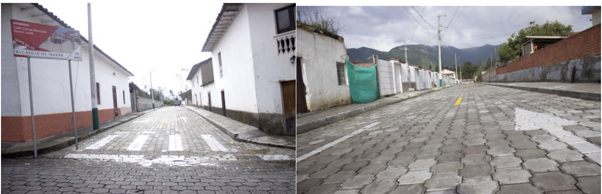
Construcción tipo Bulevar en el Barrio Rumipamba.
